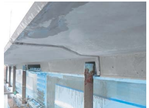
桁の添接板やパイプ等の保持金具等に干渉しないよう、ダクトスラブに切欠き実施
