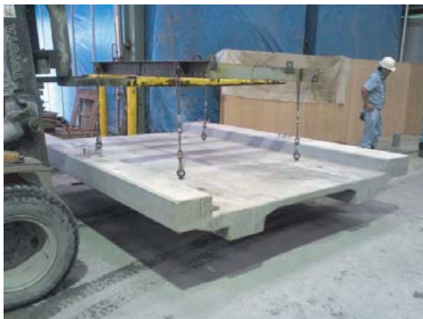
一次養生実施後に90℃、48時間の二次養生を実施
